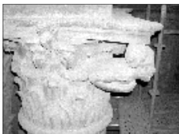
Figuras 23 a 26. Alteración de los materiales pétreos en la Portada del Perdón, formación de costras, descamaciones y fisura- ciones en frisos, pináculos y capiteles
